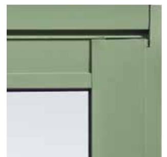
Assemblage en coupe droite
