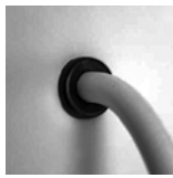
Passerelle étanchéité à l'air du câble moteur
